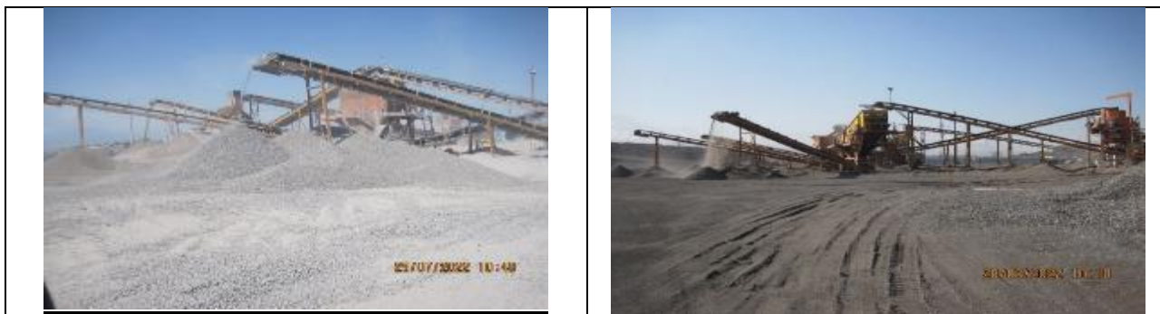
Рисунок 47 Работа камнедробильной установки на увлажненном сырье
