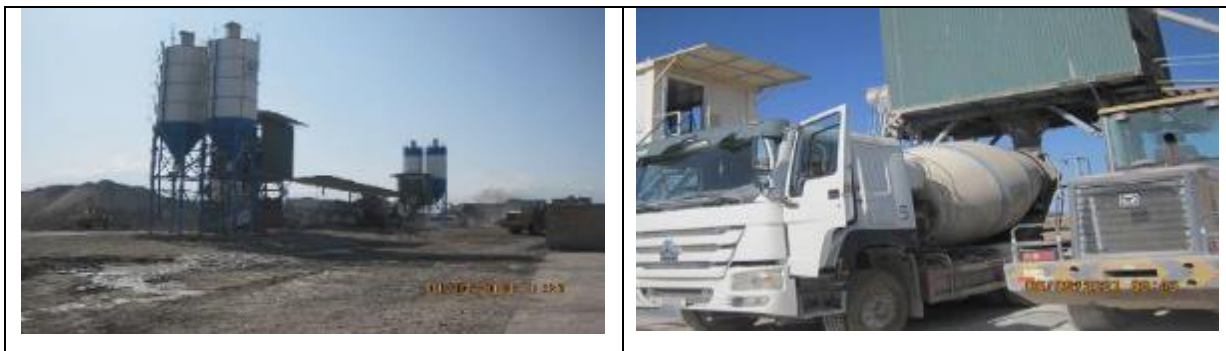
Рисунок 30 Заправка бетоном бетоносмесительной машины
