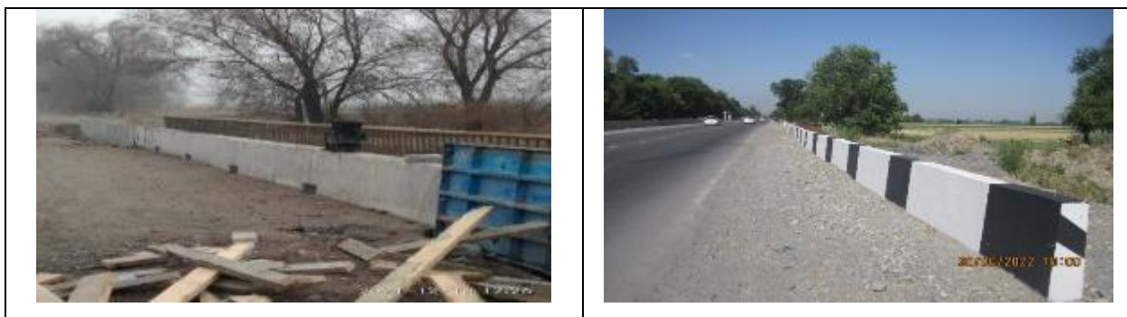
Рисунок 11 Строительство колесоотбойного парапета на р. Джеламыш
