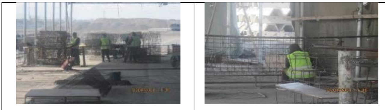
Рисунок 49 Изготовление арматурных сварных сеток, каркасов для изготовления железобетонных конструкций
