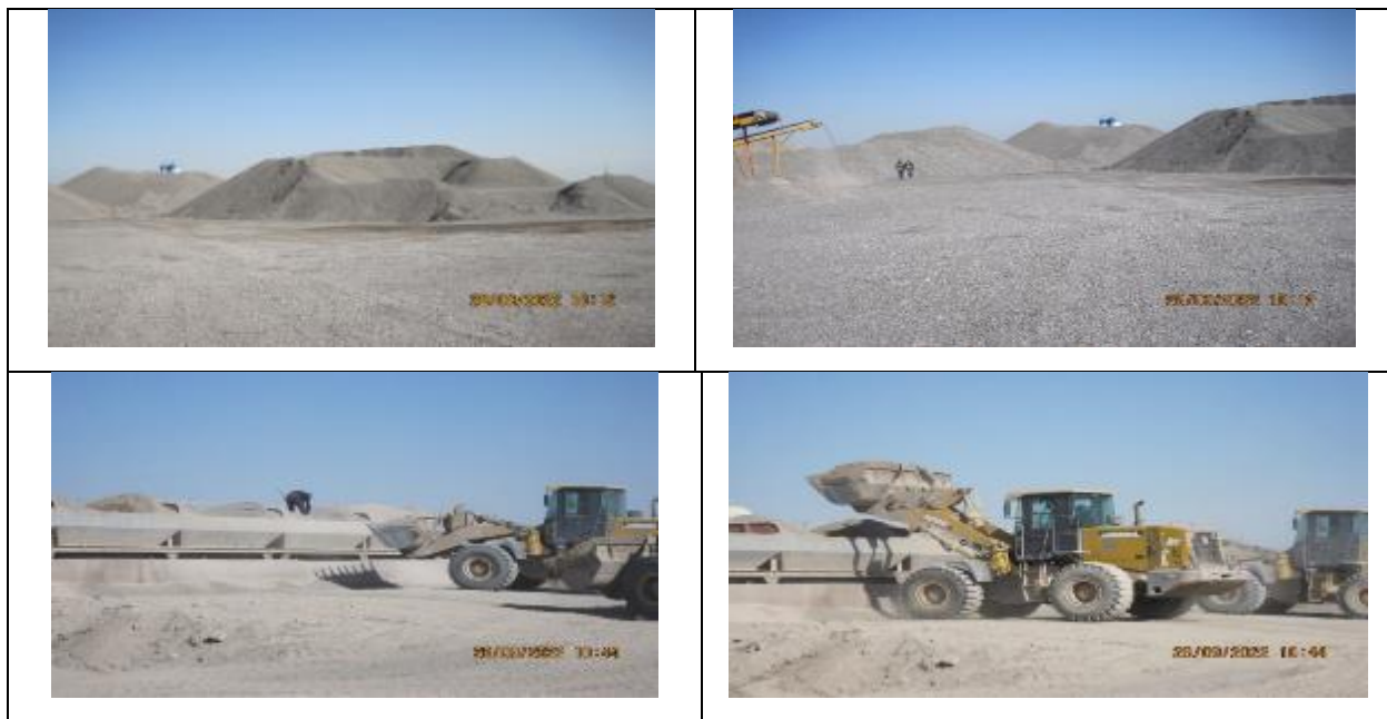
Рисунок 29 Заготовка гравийного материала для производства бетона и асфальта
