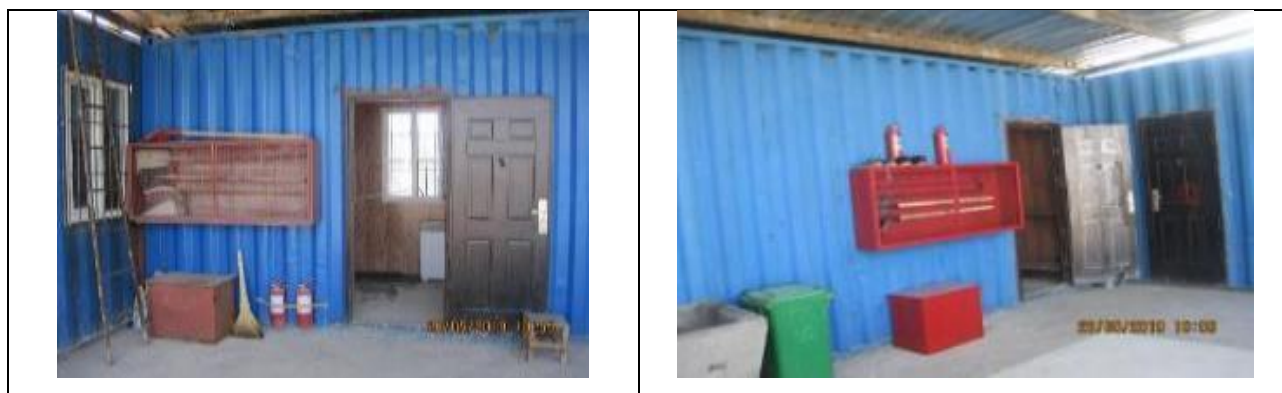
Рисунок 54 Противопожарные щиты на территории лагеря
