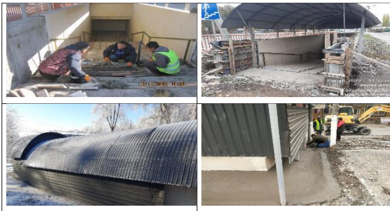
Рисунок 8 Строительные работы на подземных переходах
