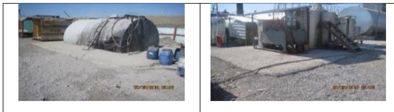
Рисунок 46 Непроницаемое защитное покрытие вокруг емкостей с химическими растворами
