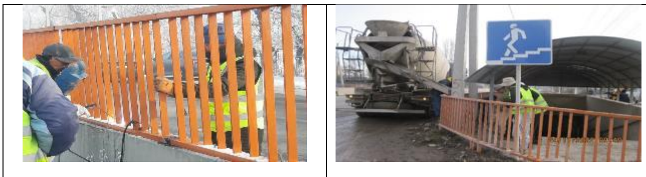
Рисунок 40 Установка металлической решетки возле подземных переходов
