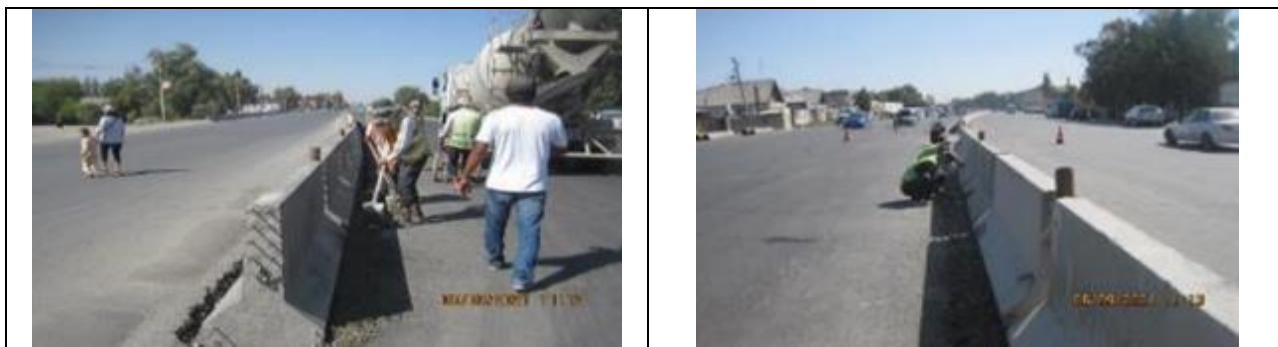
Рисунок 38 Работы по бетонированию канав на проездах между парапетами
