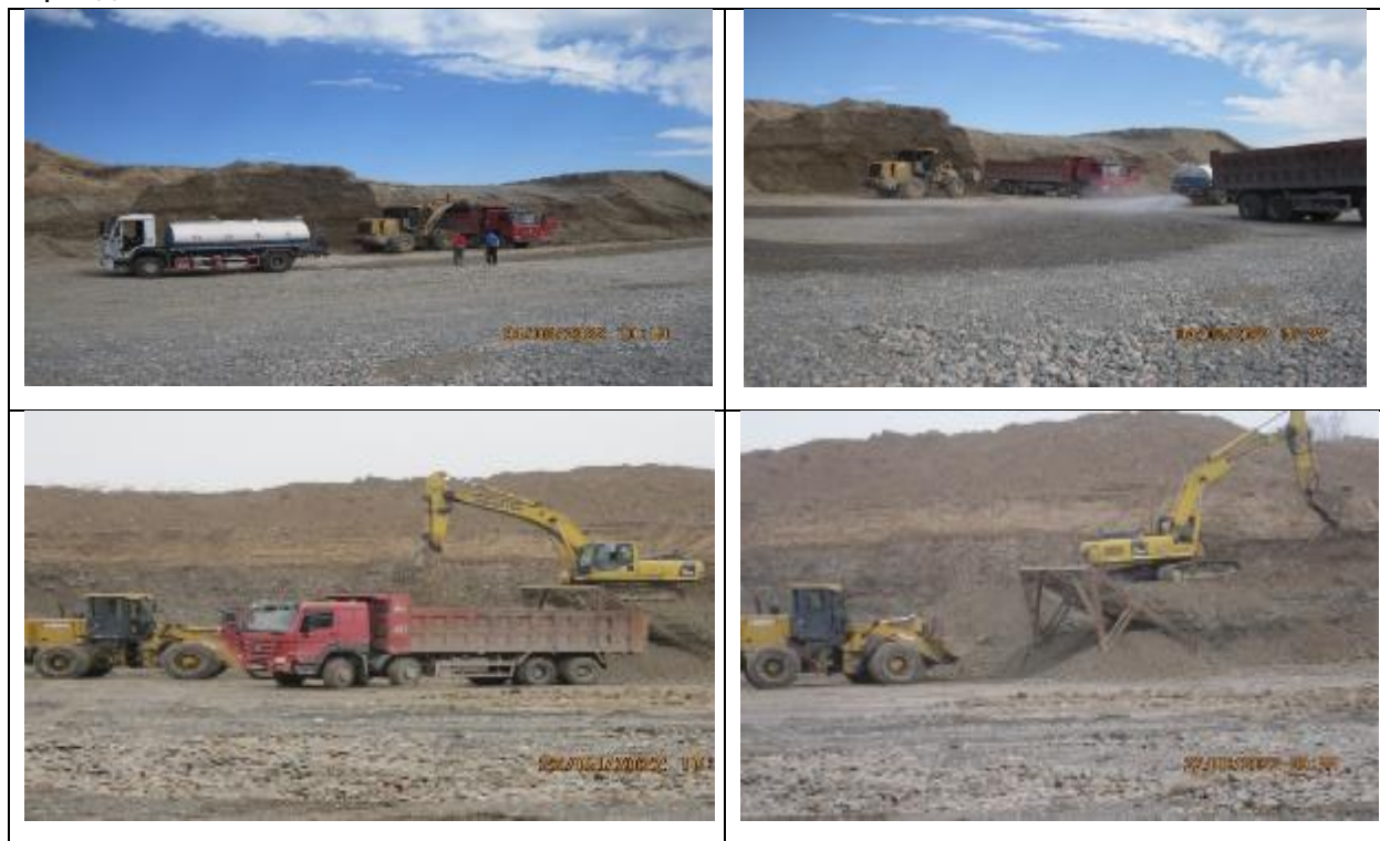
Рисунок 24 Разработка карьера Белек. Проведение работ по пылеподавлению на карьере
