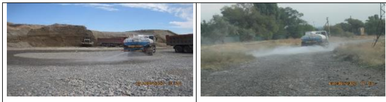
Рисунок 25 Проведение работ по пылеподавлению (гидроорошение). Дорога к карьере Белек
