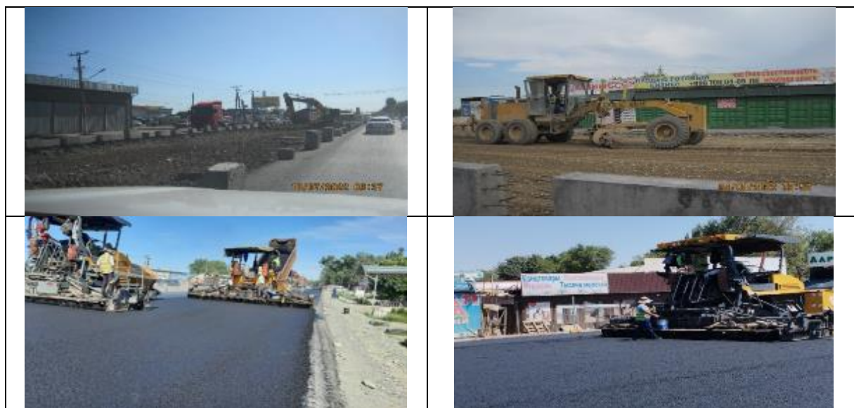
Рисунок 13 Работы по планировке и асфальтированию дорожного полотна
