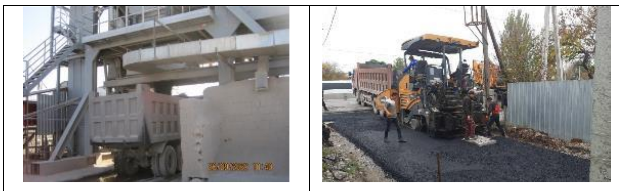
Рисунок 31 Загрузка асфальтовой смеси в самосвалы и выгрузка ее в асфальтоукладчики
