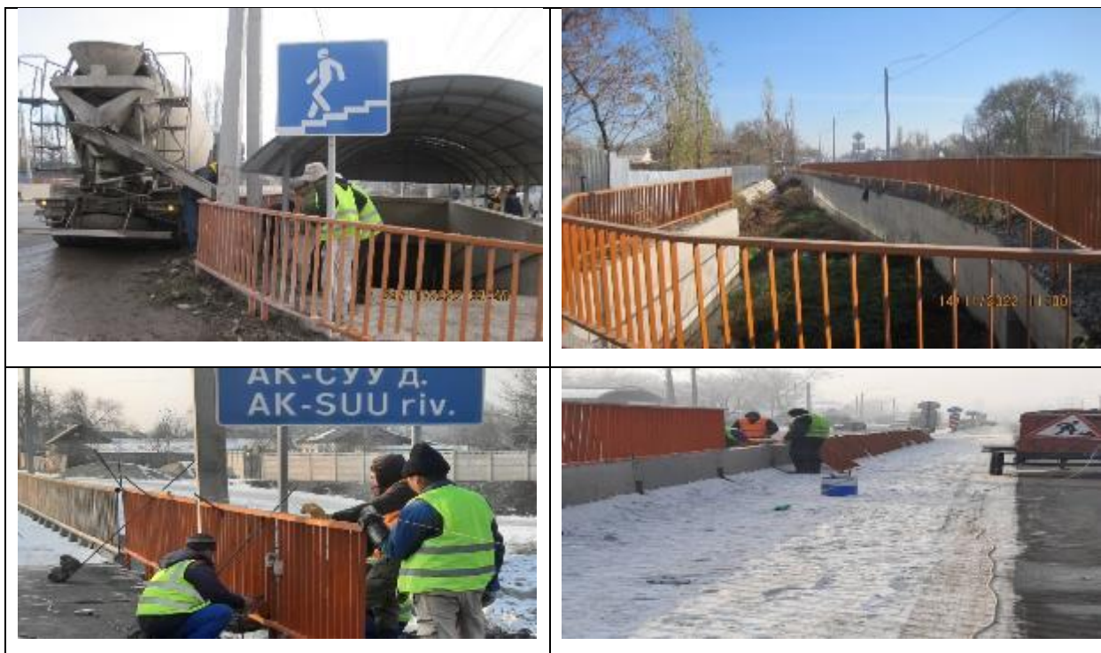
Рисунок 9 Установка металлической решетки в местах строительства дороги
