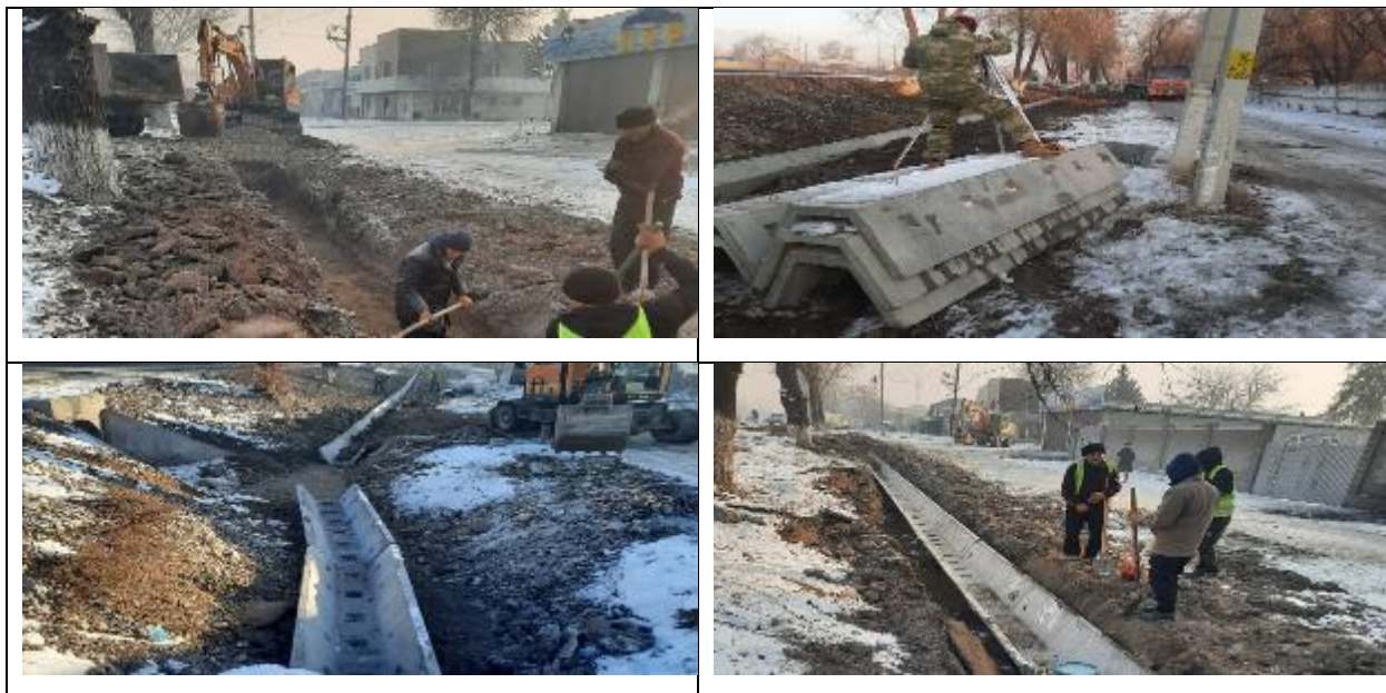
Рисунок 17 Строительство водопропускных лотков
