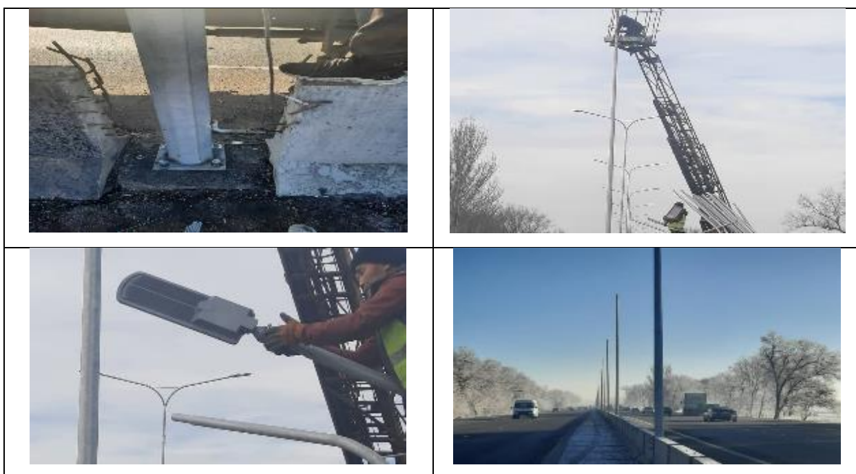
Рисунок 20 Установка основания столбов освещения и установка металлических опор под светильники освещения
