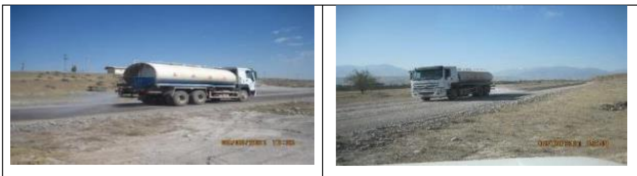
Рисунок 22 Проведение работ по пылеподавлению (гидроорошение). Дорога к производственной площадке и на карьер Ак-Суу2
