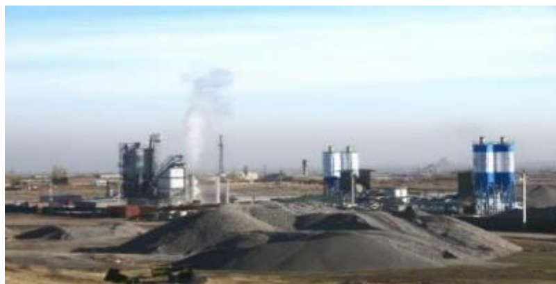
Рисунок 26 Производственная площадка. Бетонно-смесительный завод. Асфальто-битумный завод
