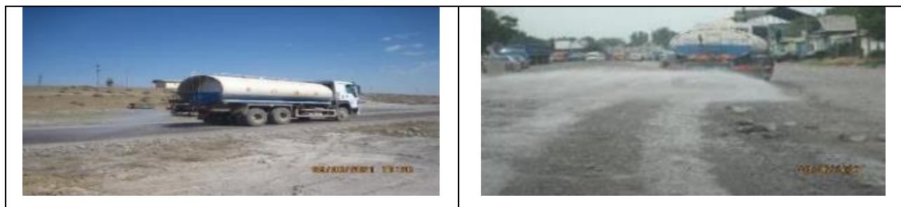
Рисунок 35 Проведение работ по пылеподавлению (гидроорошение). Дорога на производственную площадку и на участке строительства дороги в с. Военно-Антоновка
