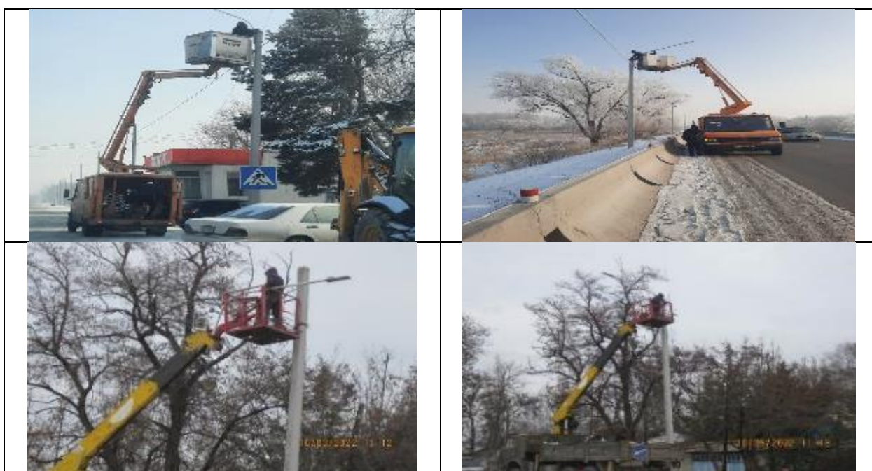
Рисунок 12 Проведение работ по уличному освещению. Установка светильников
