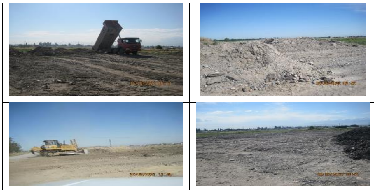
Рисунок 65 Складеирование и планировка непригодного грунта для дальнейшего использования в с. Военно-Антоновка
