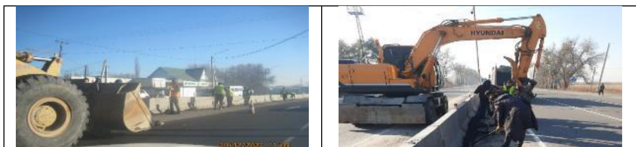
Рисунок 36 Очистка парапетов от земляных отходов и вывоз отходов с дороги
