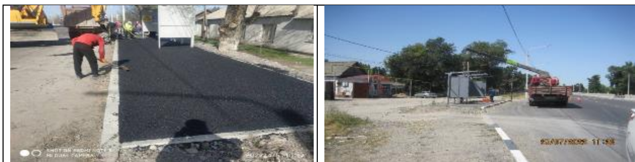
Рисунок 3 Асфальтирование остановочных площадок
