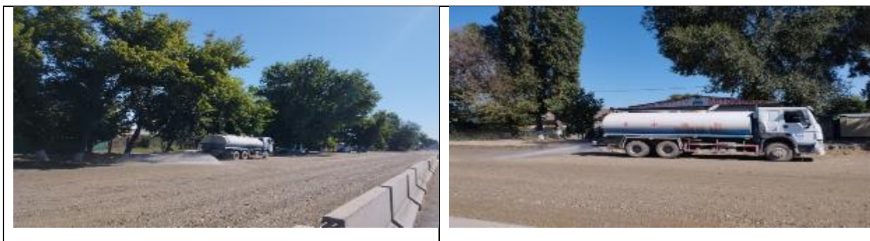
Рисунок 21 Проведение работ по пылеподавлению (гидроорошение) на участке строительства
