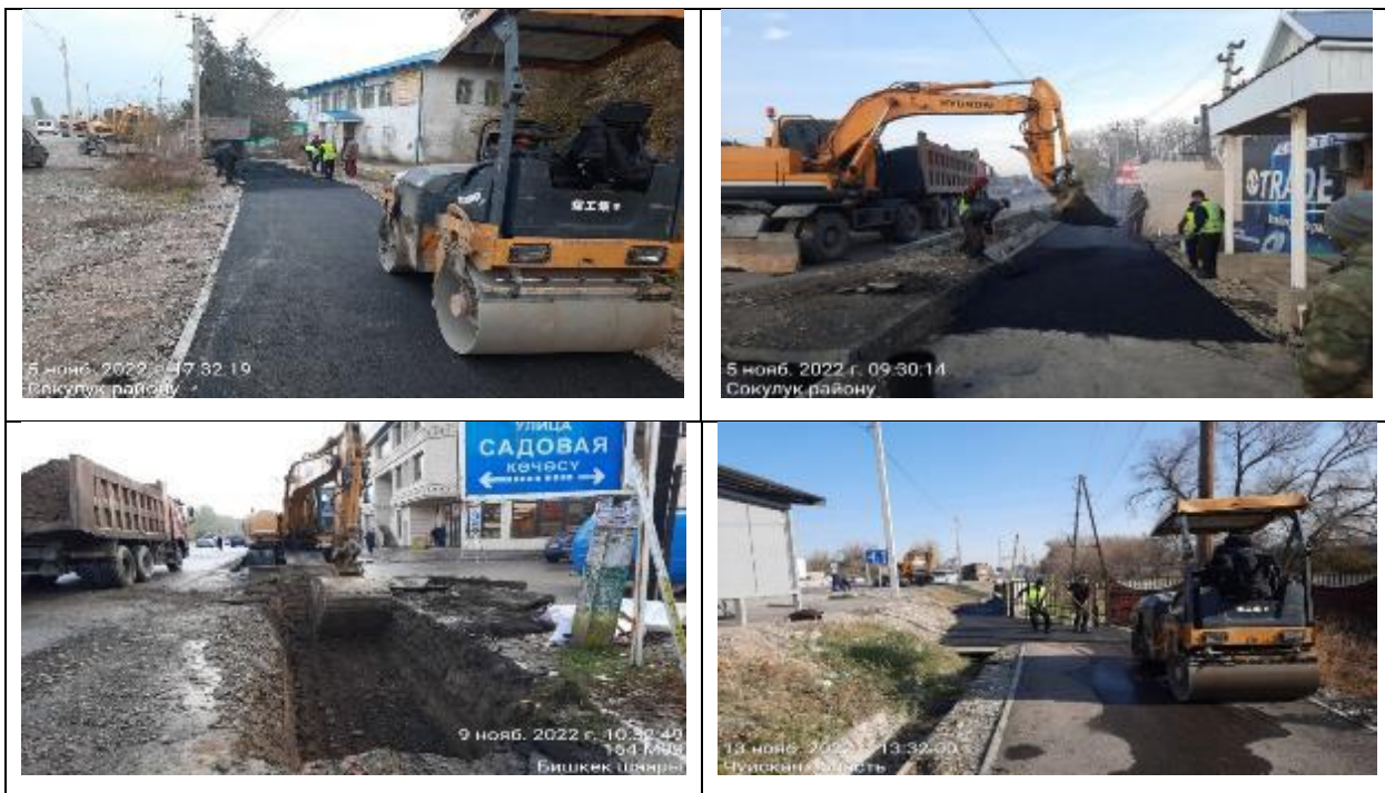
Рисунок 18 Работы по асфальтированию тротуаров
