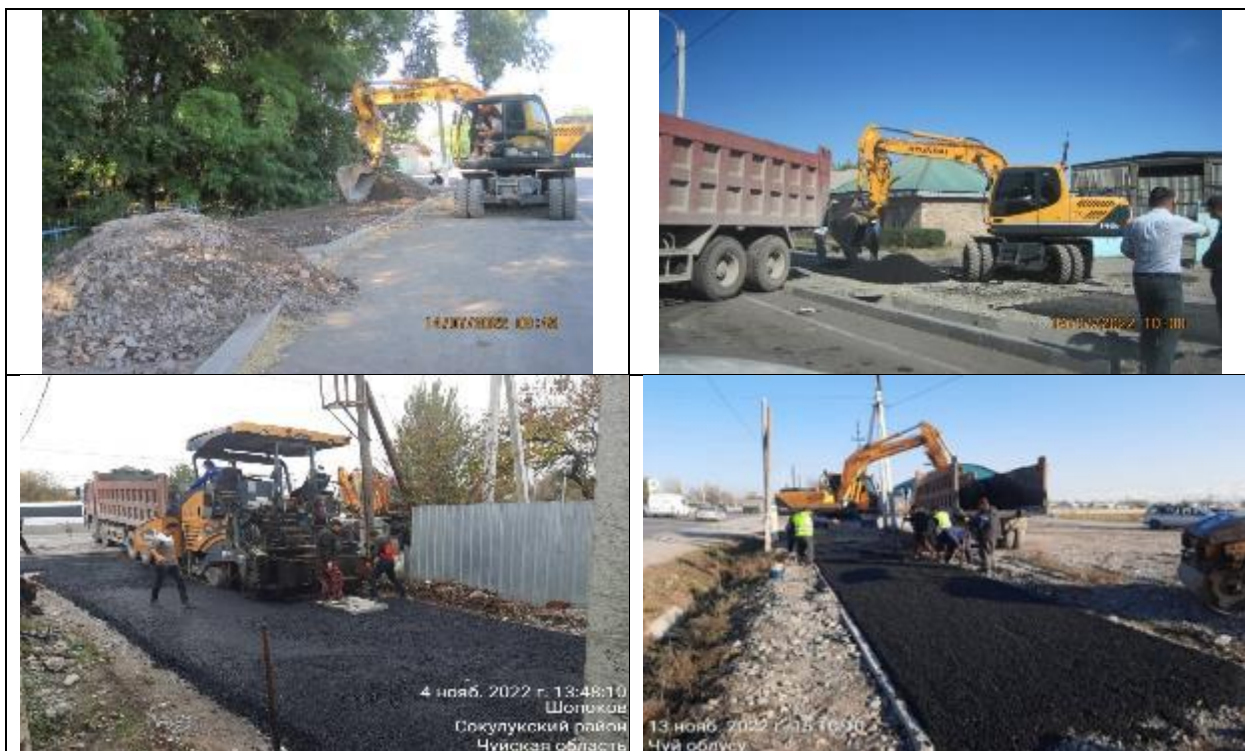
Рисунок 7 Строительство тротуаров
