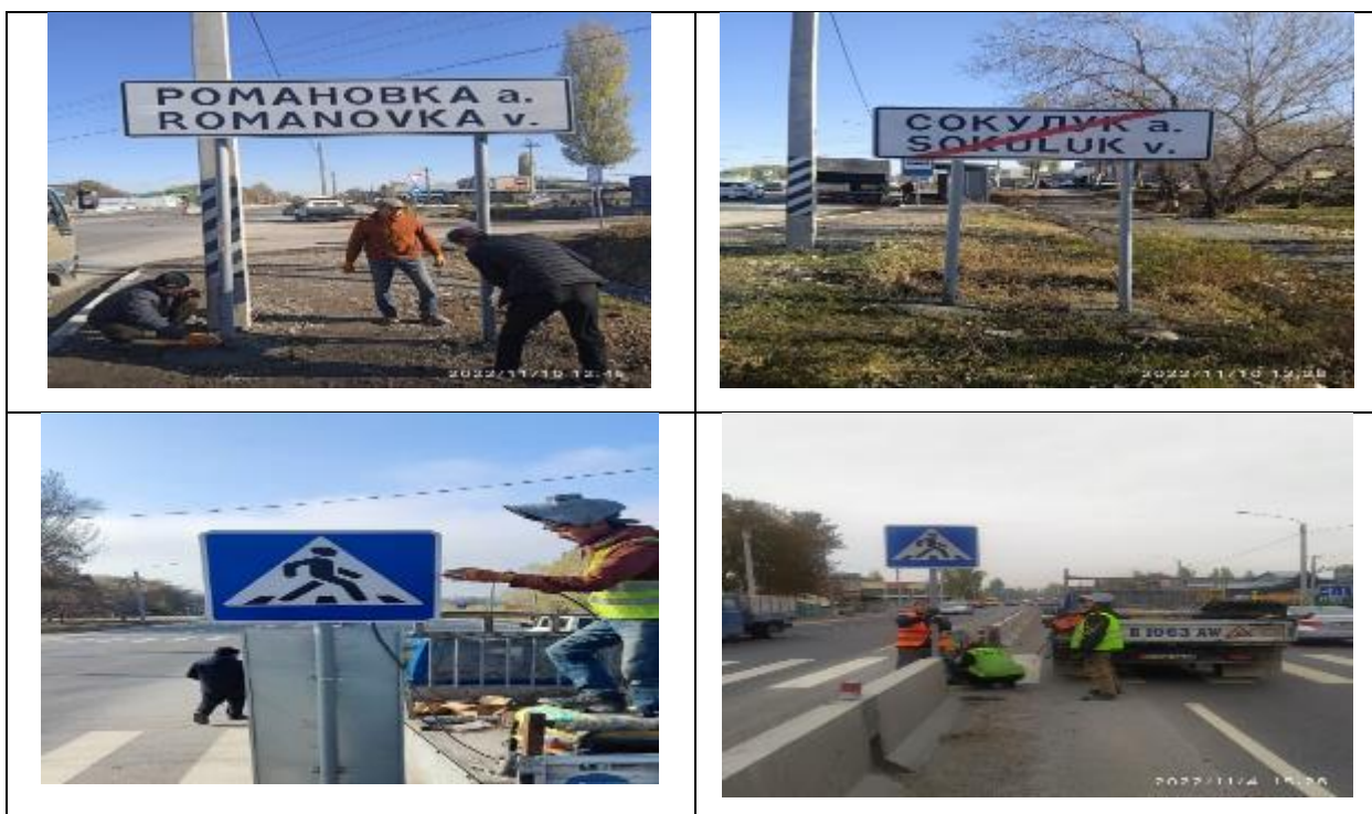
Рисунок 10 Установка дорожных знаков и указателей на проектной дороге
