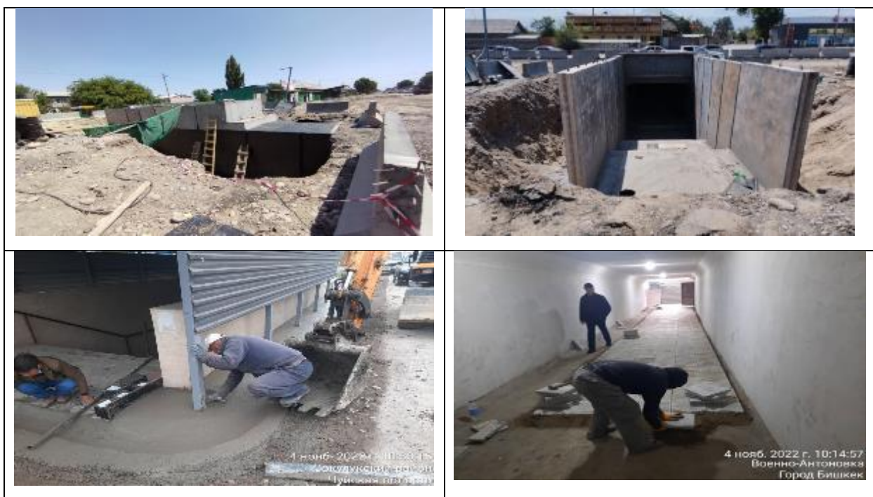
Рисунок 15 Строительство подземного перехода
