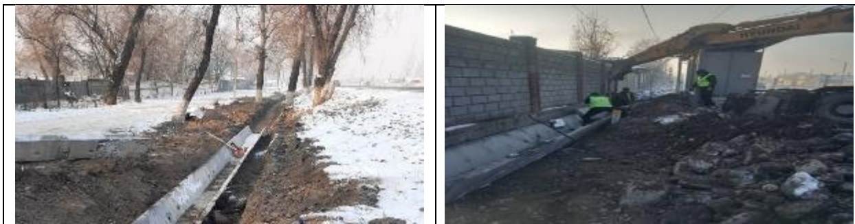
Рисунок 4 Строительство водопропускных лотков
